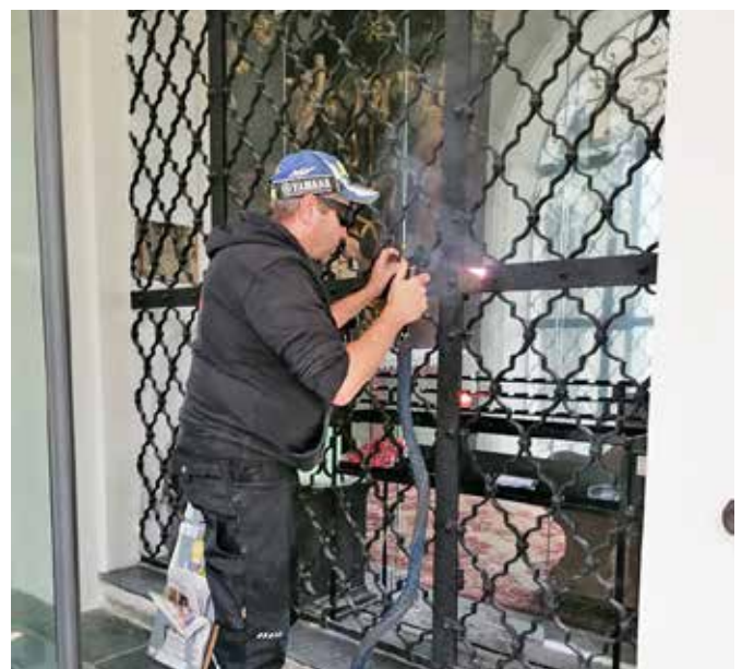
Bei den schmiedeeisernen Gittern mit Verzierungen wird mittels Laser die Farbe entfernt, damit bei der Neulackierung die Verzierung wieder zu erkennen ist.
