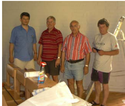
Bau der Kapelle 2005
